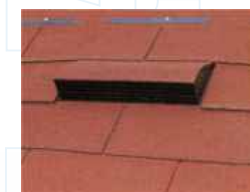
Aeratore standard Fig.48
